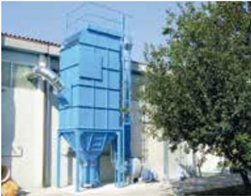
Impianto di filtrazione polveri ceramica
