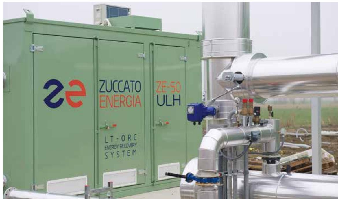
Serie ULH per diverse applicazioni: a Mantova per recupero termico da camicie e fumi di motori a biogas, a Merano per motori ad olio vegetale
