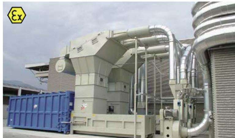
Impianti per trasporto e recupero pneumatico di rifili in legatoria, con pressa scarrabile
