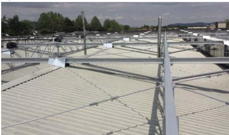
*Carpenteria strutturale a rinforzo copertura esistente*
