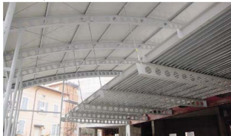
*Copertura con struttura a centine forate*
