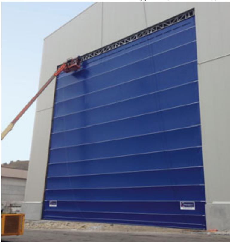
Barre in acciaio zincato inserite nel telo permettono a questa porta di offrire elevata resistenza al vento
