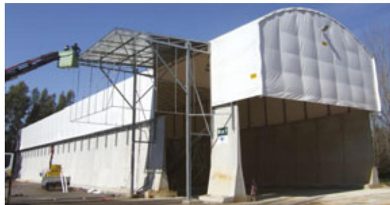
Grande copertura speciale con telo in PVC e struttura in carpenteria metallica
