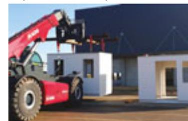
Esempio di possibile posizionamento di monoblocco
