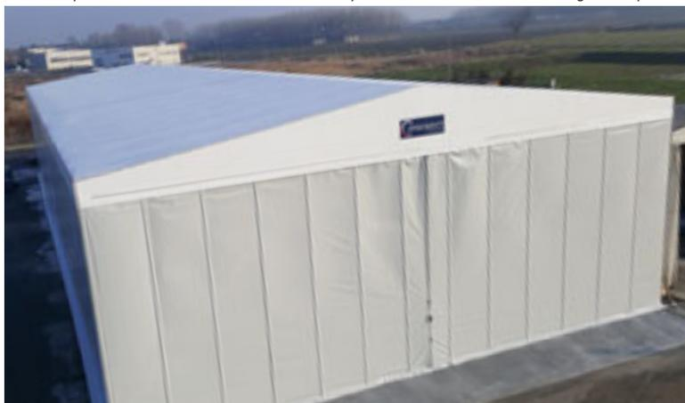
*Telo di copertura in Trevira spalmata con doppio strato di PVC autoestinguente in Classe II*
