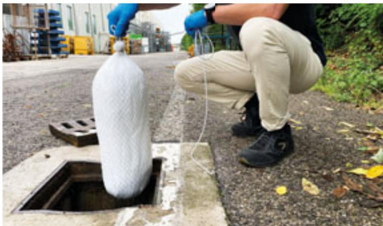
Assorbenti galleggianti in materiale idrorepellente per pozzetti
