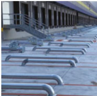
Sistemi di bloccaggio camion
