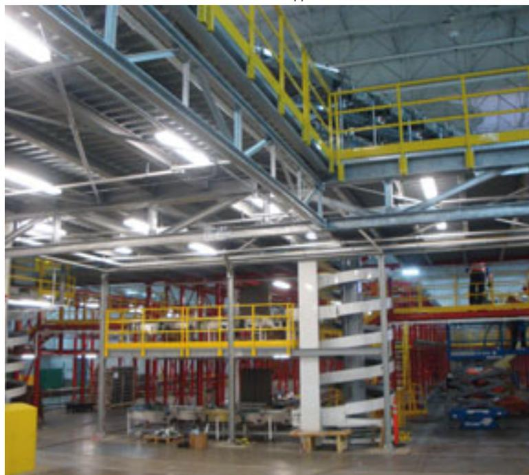
*Soppalco tecnico complementare a impianti di lavorazione*
