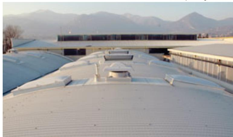
*Estrattore elicoidale da tetto Aerflux*
